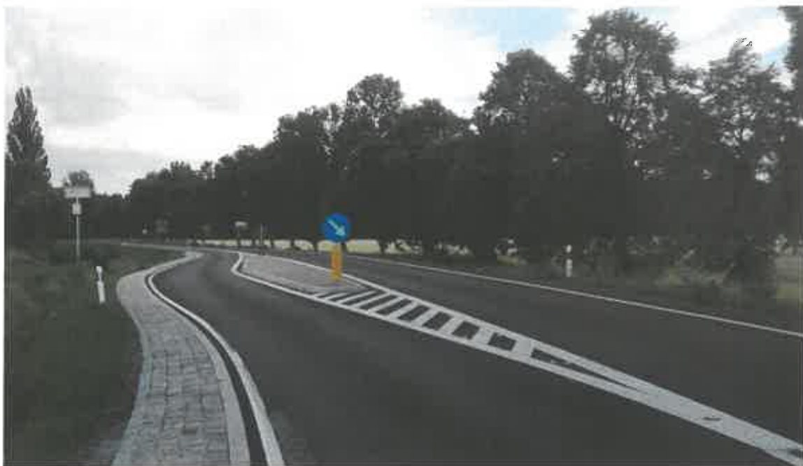
Ilustracja 4 Uspokojenie ruchu przy wjeździe do miejscowości
