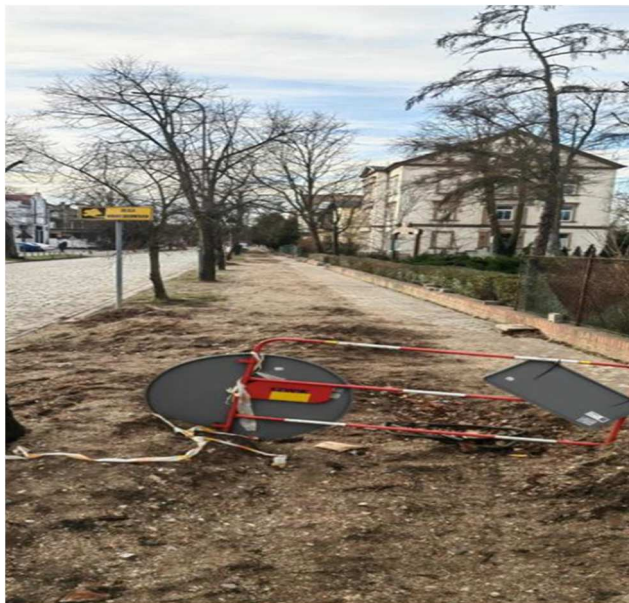
Zdjęcie 2 Modernizacja ul. Niepodległości w Szprotawie
