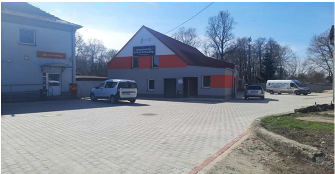
Zdjęcie 19 Budynek OSP w Lesznie Górnym
