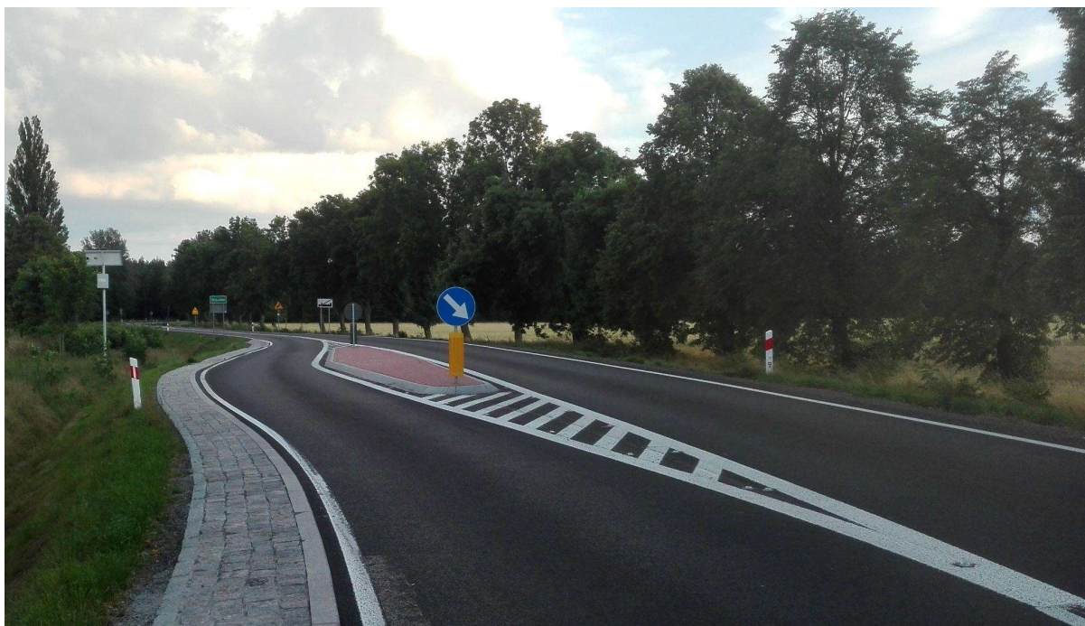
Ilustracja 4 Uspokojenie ruchu przy wjeździe do miejscowości
