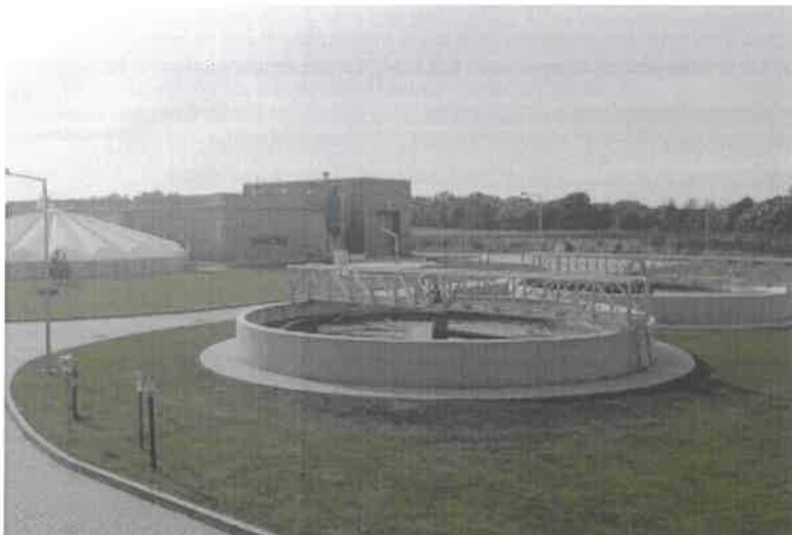
Zdjęcie 19 Oczyszczalnia ścieków w Wiechlicach
