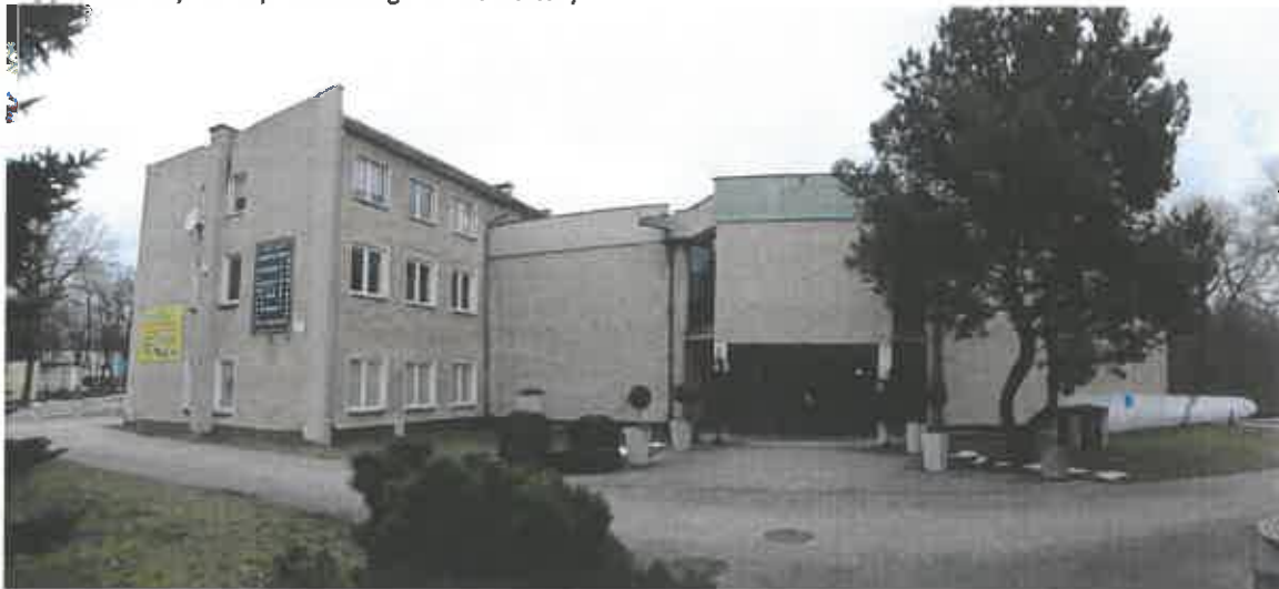
Zdjęcie 10 budynek Szprotawskiego Domu Kultury
