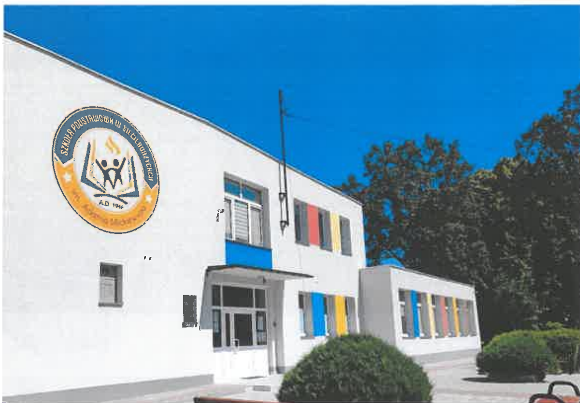
Zdjęcie 5 Zdjęcie budynku Szkoły Podstawowej w Siecieorzycach
