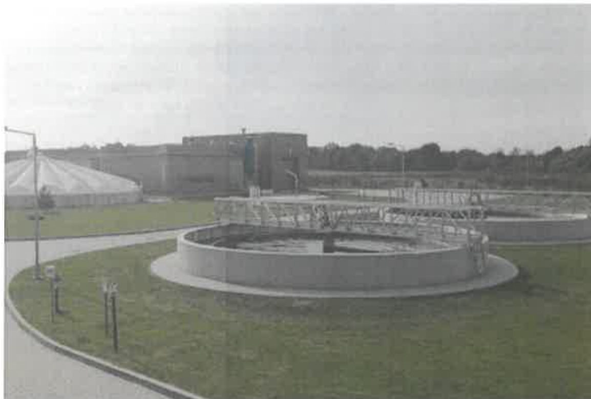
Zdjęcie 19 Oczyszczalnia ścieków w Wiechlicach
