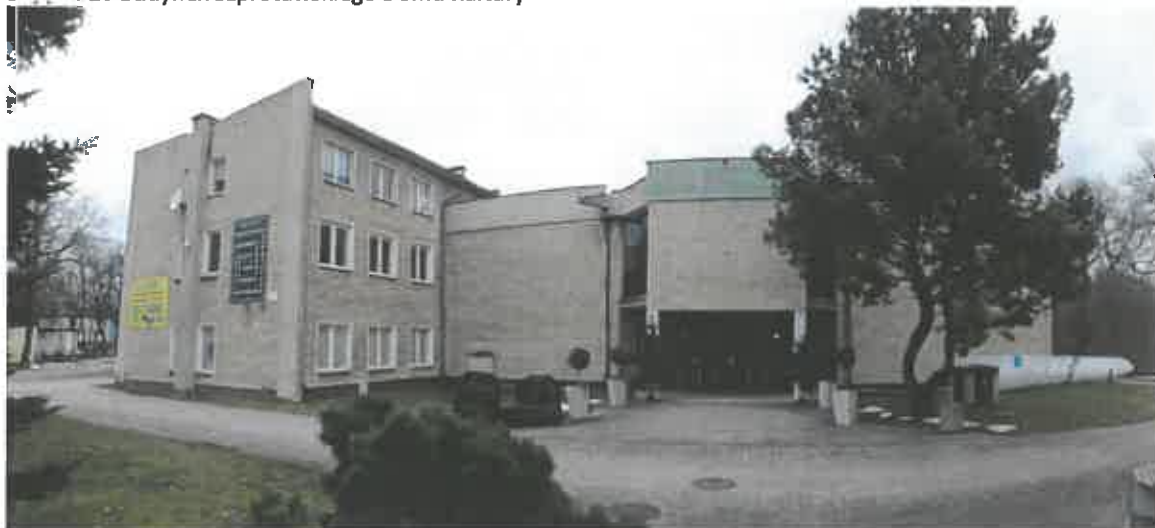
Zdjęcie 10 budynek Szprotawskiego Domu Kultury
